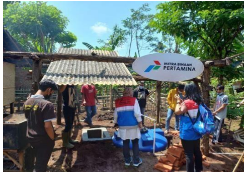
Gambar 9. Kegiatan Pemasangan Instalasi Biogas di Lingkungan Papring
