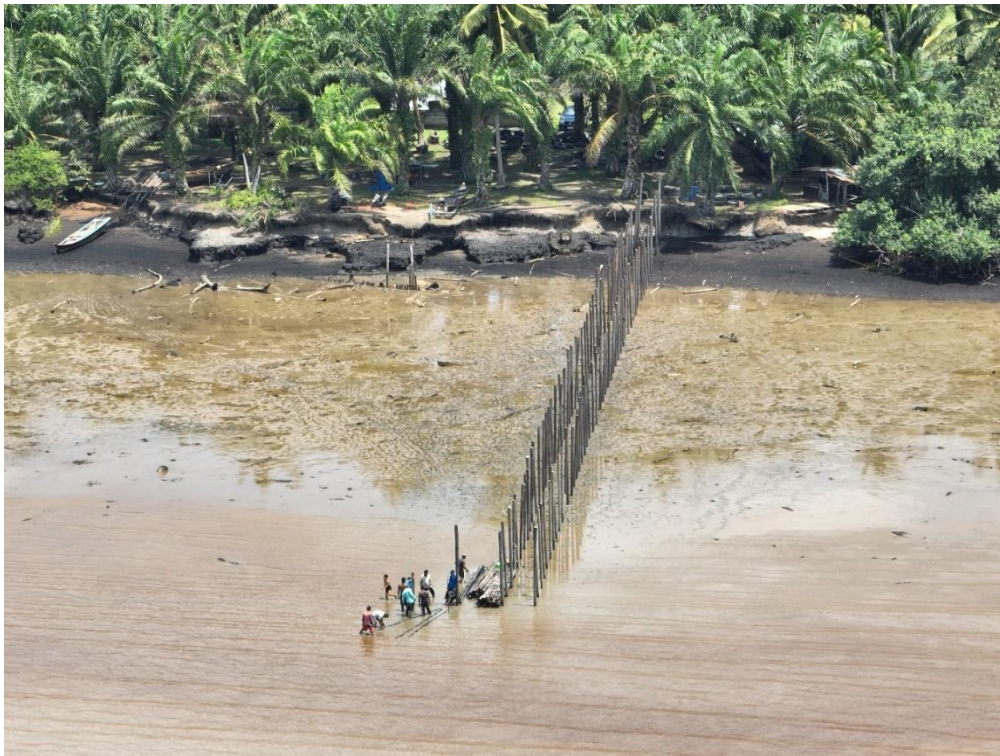
Gambar 4. Pemasangan Dermaga dan Alat Pemecah Ombak oleh Kelompok Nelayan di Kelurahan Mundam
