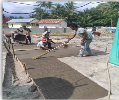
Gambar 3. Proses Pengecoran TPA Desa Pegantungan yang Memberdayakan Masyarakat Sekitar
