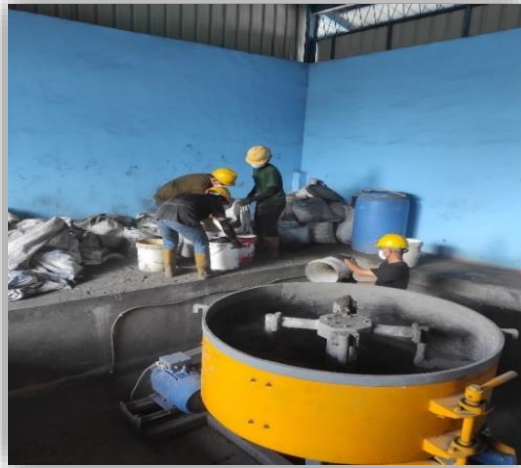
Gambar 1. Kegiatan Workshop Pelatihan Pembuatan Batako dan Paving Block Sumber: Dokumentasi PT PJB Services PLTU Suge Belitung, 2021
