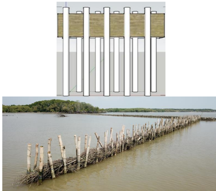
Gambar 4. Skema Pemasangan Hybrid Engineering dan Hasil Implementasinya Sumber: Dokumentasi Peneliti, 2024
