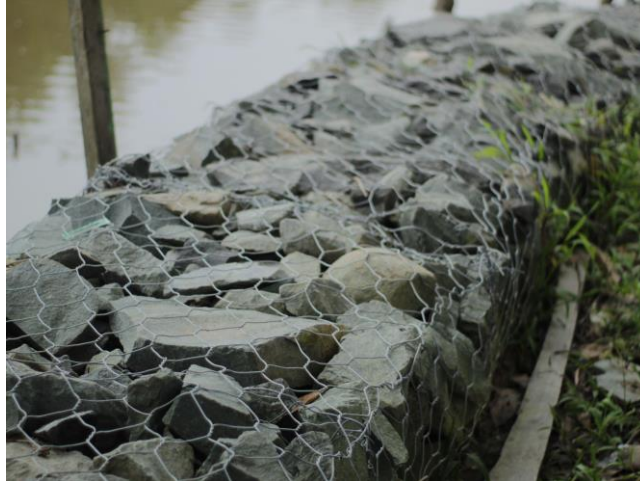
Gambar 3. Turap Bronjong di Sekitar Pulau Semut Sumber: Dokumentasi Pribadi, 2023
