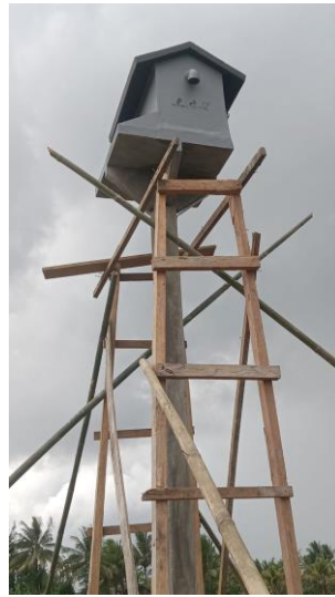
Gambar 3. Proses Konstruksi Rumah Serak Sulawesi Sumber: Dokumentasi JOB Tomori
