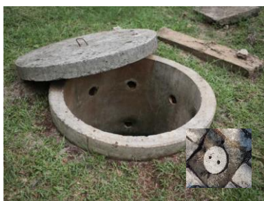
Gambar 1. Dokumentasi Sumur Resapan dan Biopori di Kecamatan Tanggulangin Sumber: Data Riset Lapangan 2023
