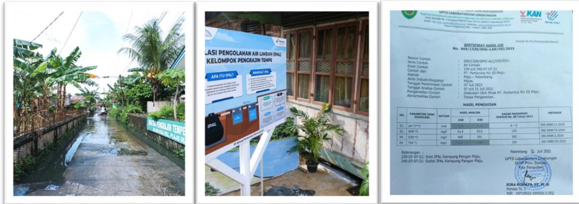
Gambar 3. Kondisi Sebelum Program, IPAL, Hasil Uji Lab (Sumber: Penulis, 2021)
