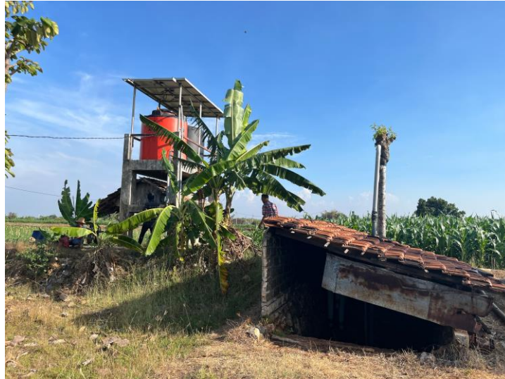
Gambar 3. PLTS dan Sumur Bor untuk Pengairan Pertanian Jagung Dusun Semangke Sumber: Dokumentasi Penulis, 2024
