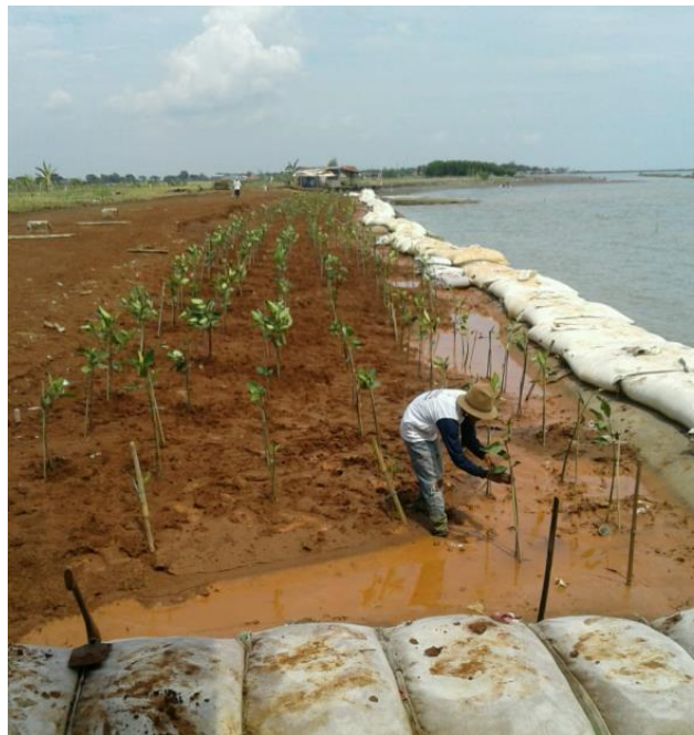
Gambar 3. Penanaman Mangrove Setelah Pemasangan Geotube Tahun 2020 (Sumber: Dokumentasi Pertagas OWJA, 2022)
